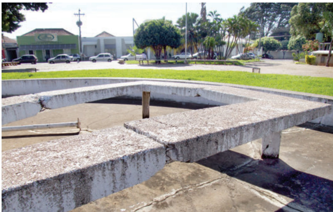
Fonte danificada na mal cuidada praça "Euphly Jalles": risco ao povo e aos cofres públicos
