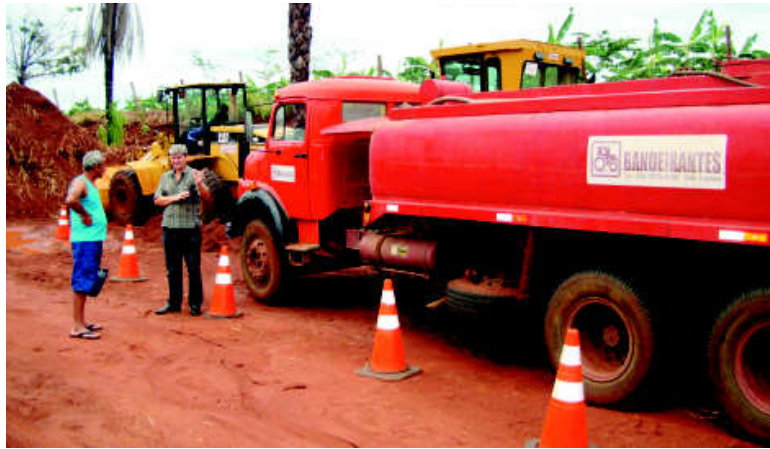
Consórcio Bandeirantes já instalou canteiro de obras em Santa Fé do Sul
